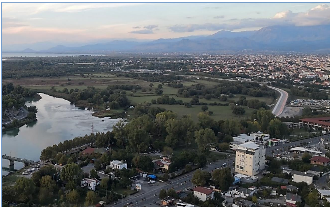
Figura 19: Pamje e bajpasit perëndimor (në ndërtim) të qytetit të Shkodrës [foto: INFRASTRUKTUR & UMWELT]
