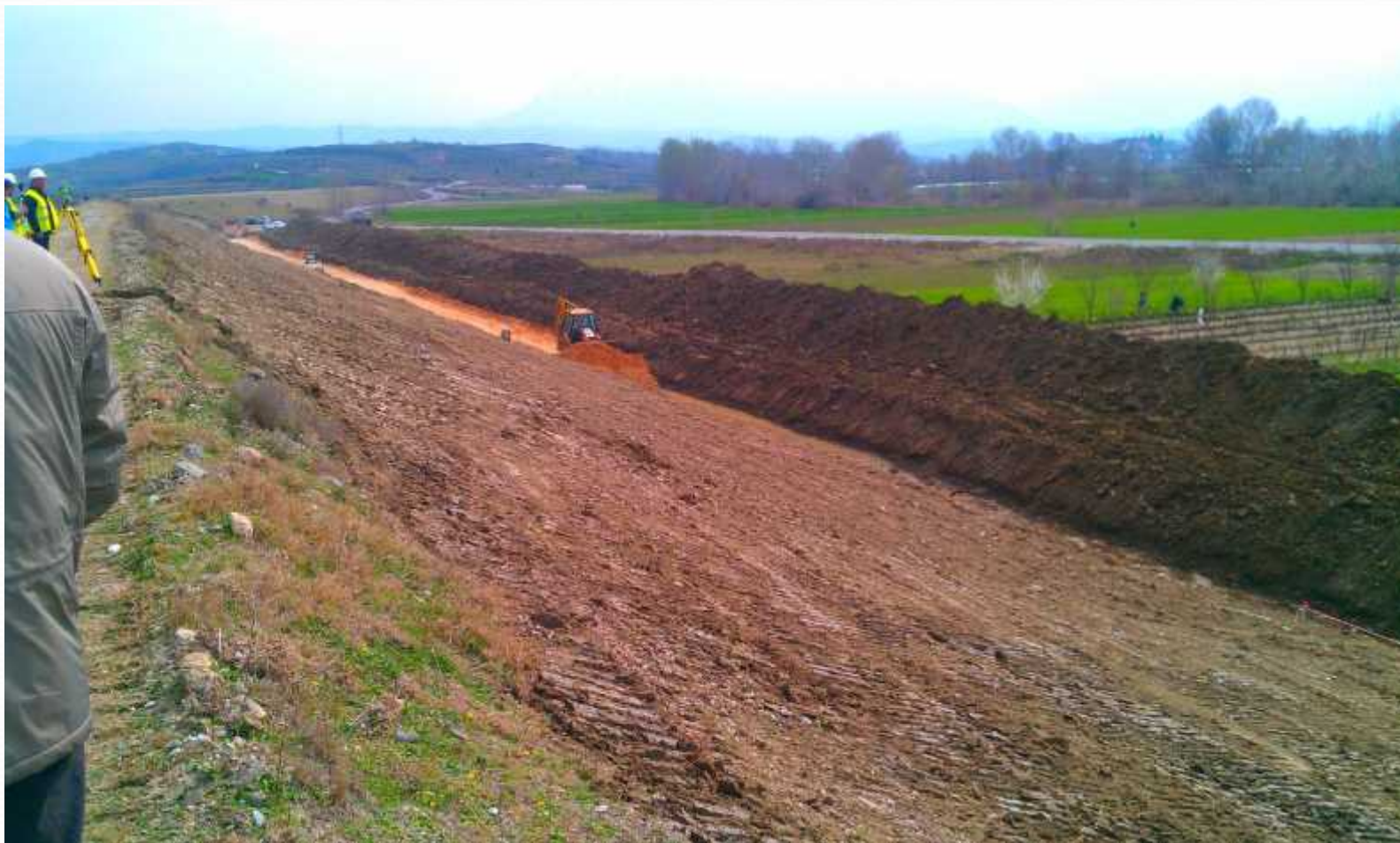
Diga Thanë. Punime për riparimin e shkarjes, kontrabankinë dhe drenazhim
