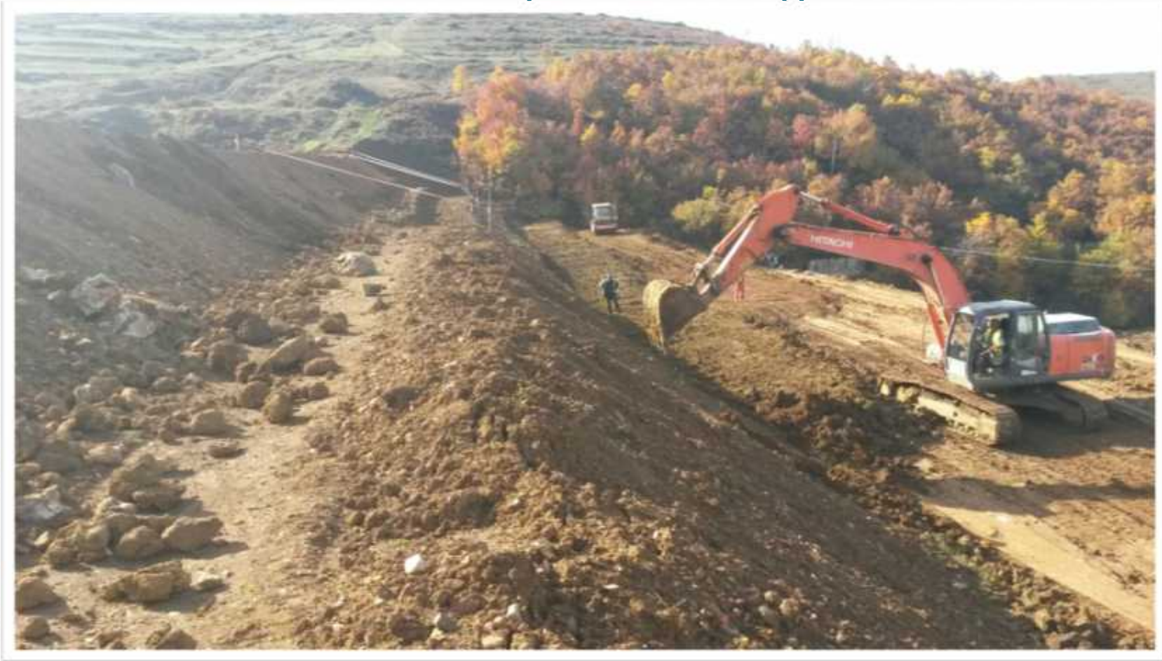
Diga Vranisht. Punime për rehabilitimin e digës
