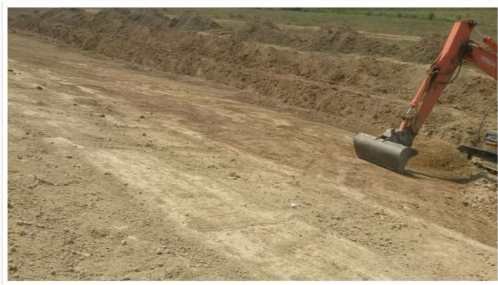
Diga Kurjan. Punime sistemi dhe drenazhimi në digë
