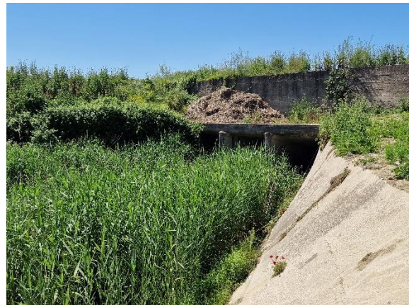
Figura 5 - Kanali i kullimit që rrjedh përmes një sifoni nën Lumit Gjanica.
