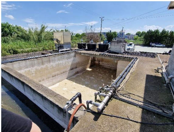
Figurë 4 - Impiantin e vet të trajtimit të ujërave të ndotura, Fabrika e bulmetit Lufra (trajtim bazë të nivelit të dytë).
