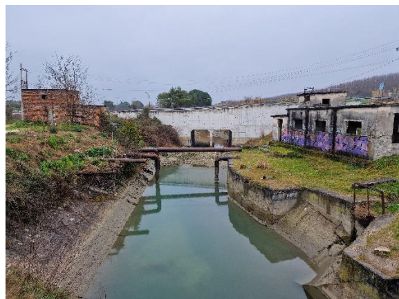
Figura 18 - Kanal anësor dhe mbetje të vjetra të stacioneve të pompimit.
