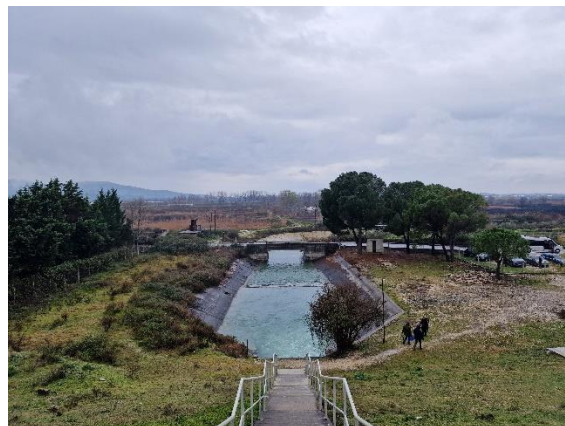
Figura 11 - Kanali kryesor i ujitjes poshtë digës.
